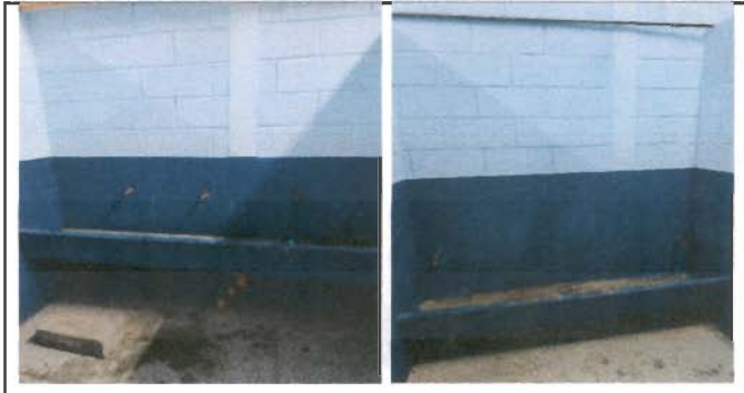
Foto 6: Sustrucción de azulejo
