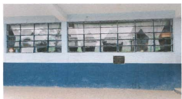
Foto 2: Sustrucción de balcon y ventana para aula 2 en modulo 2
