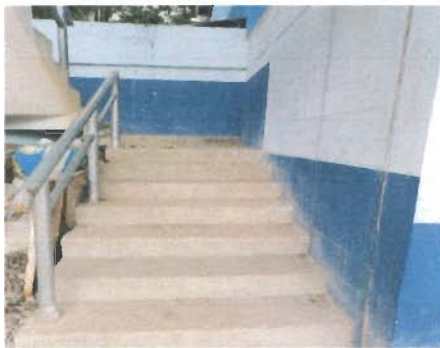
Foto 3: Sustrucción piso torta por granito
