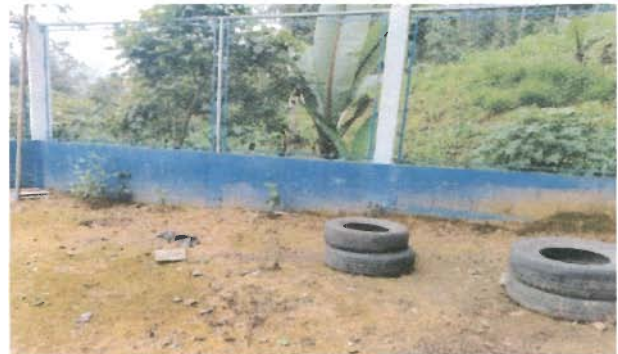
Foto 4: Pintura en muros exteriores e interiores
