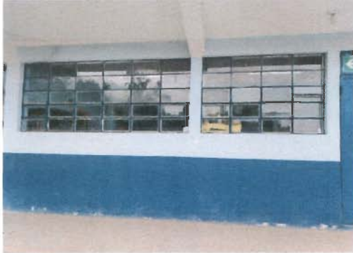
Foto 1: Sustrucción de balcon y ventana para aula 1 en modulo 2
