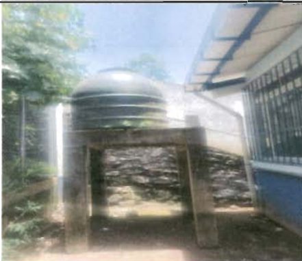
Foto 9: Sustitución de depósito de agua de 2500 lt
