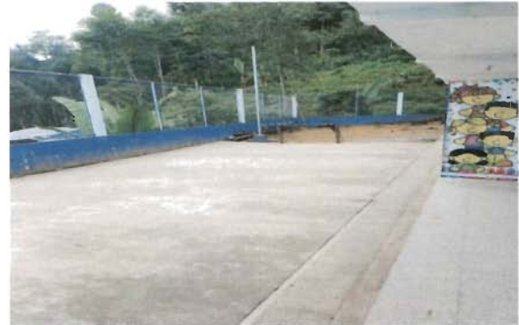
Foto 8: Reparación de planchas de concreto de patio
