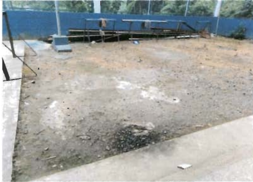
Foto 7: Reparación de planchas de concreto de patio
