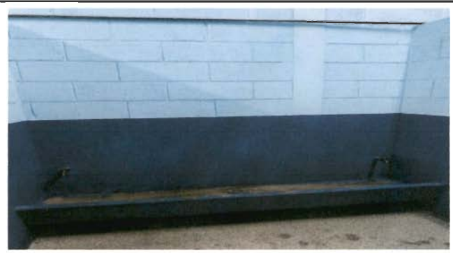
Foto 11 Sustitución de llave en mingitorio
