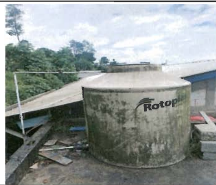
Foto 10: Sustitución de accesorios depósito de agua
